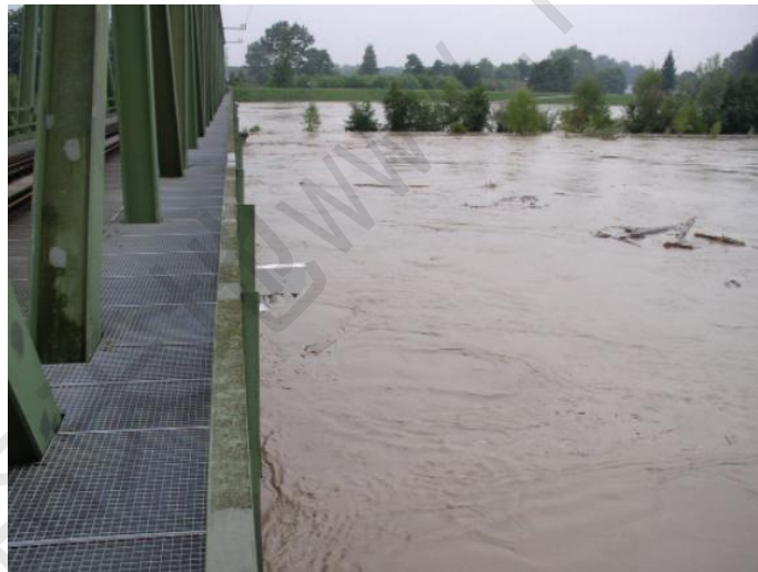
图 4 RQ-30 现场安装图
