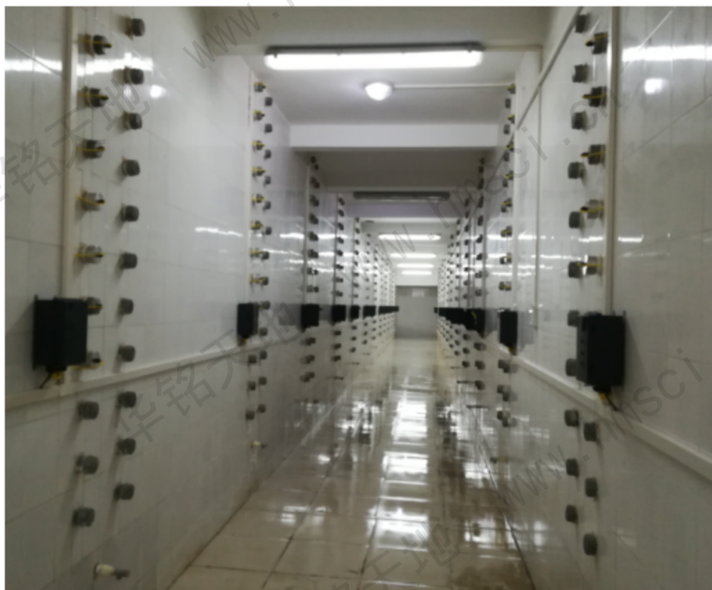
图2 大型蒸渗仪矩阵式土壤温湿盐系统
